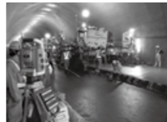
情報化施工の活用 (TS) ▶P. 5
