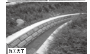
カーブ施工が容易な環境配慮型の 練積みブロック▶P.24
